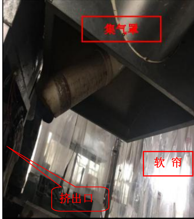
图 4-2 有机废气收集方式实例图（网络收集）
