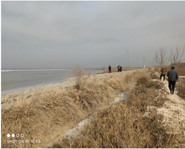
拟建防洪工程区域现状
