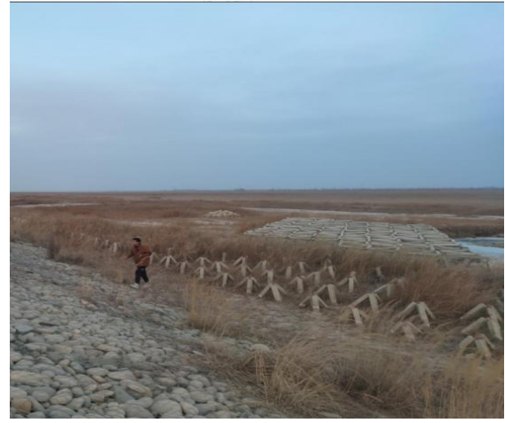
拟建防洪工程区域现状
