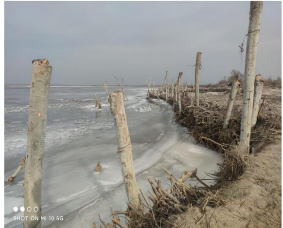
拟建防洪工程区域现状
