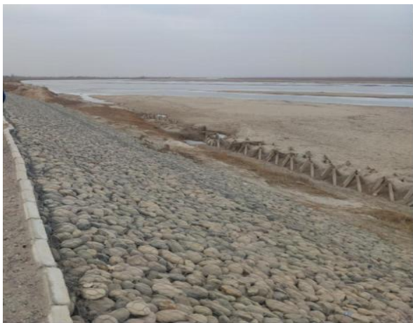
拟建防洪工程区域现状
