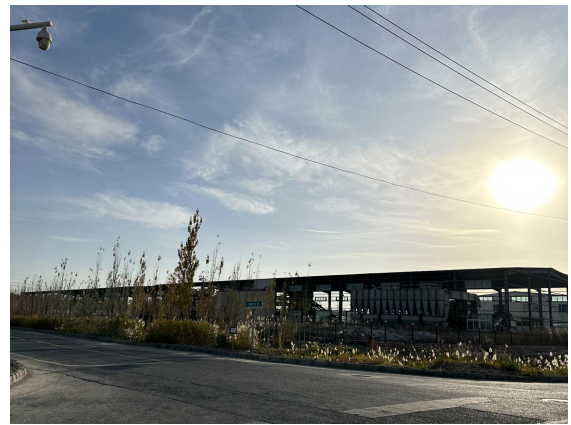
图4 项目区西侧在建厂房
