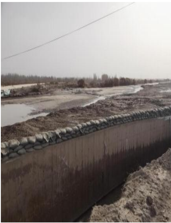
项目所在区域现状（老闸现状）
