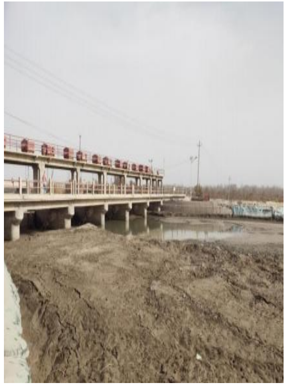
项目所在区域现状（老闸现状）
