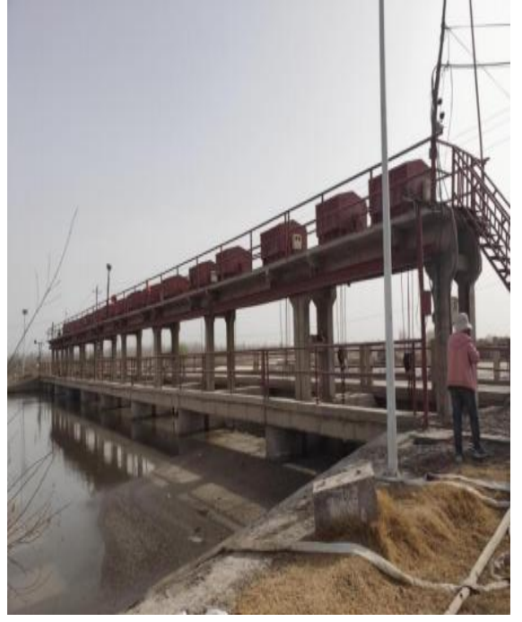
项目所在区域现状（老闸现状）
