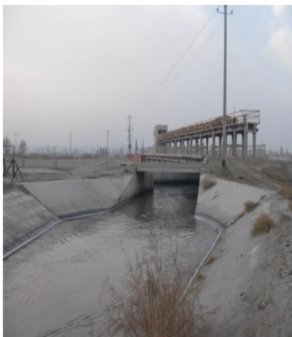
项目所在区域现状（老闸现状）
